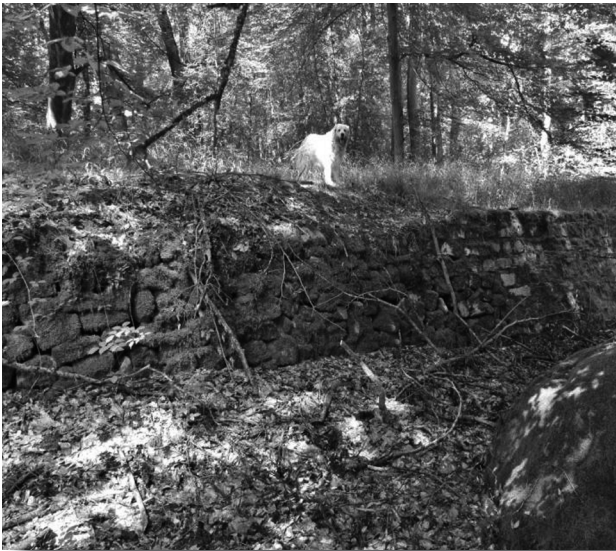
Photo n° 2 : Mur de soutènement
