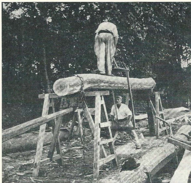
Scieurs de long. Débitage d'une poutre. Photo BODMER 1909 (Collect. de l'auteur).
