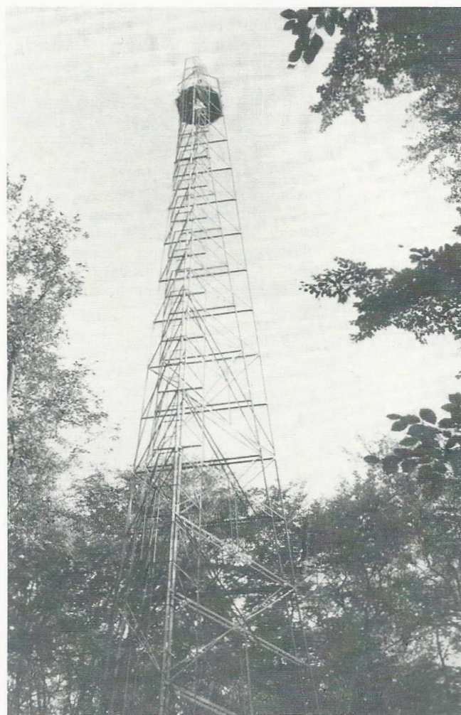
Le pylône tripode de 45 m expérimenté en novembre 1983 sur le plateau d'Augas.
